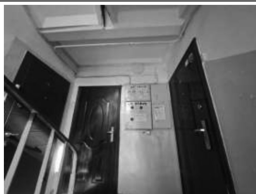
1.stāva kāpņu telpa
